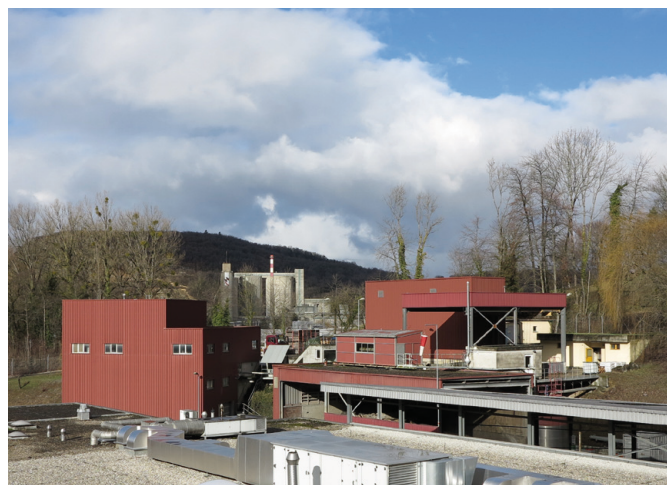
Site de CRIDEC SA; à l'arrière-plan, la cimenterie à Eclépens. Toutes les photos: Márton Varga, Topmotors
